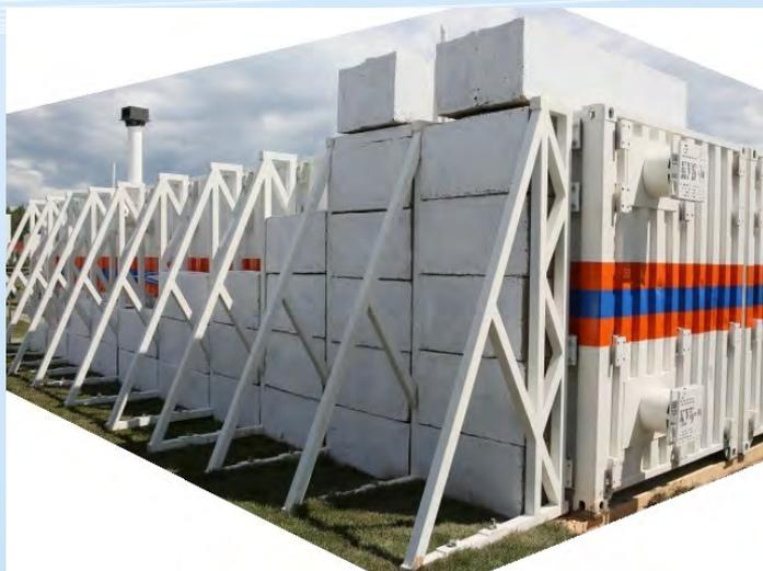
Убежище назвали «КУБ-М». Оно рассчитано на 54 человека, оборудовано необходимыми системами жизнеобеспечения: фильтровентиляции воздуха, водоснабжения, канализации и отопления. Куб снабжен дизельной установкой и может функционировать автономно 2-е суток.
